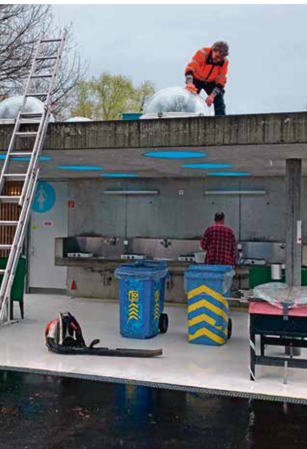
Letzte kosmetische Arbeiten
