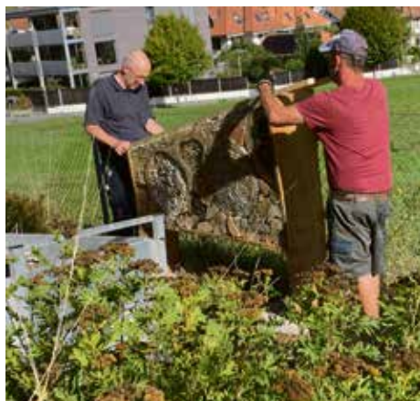
Aufstellen des Hauses
