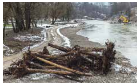
Wurzelstöcke werden im Flussbett verankert und bieten künftig gute Laichplätze für Fische.
