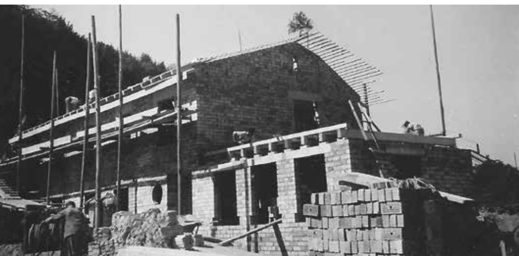
Kirche im Bau
