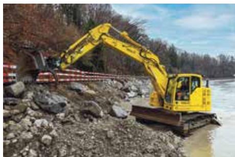
Massarbeit: Die Uferverbauung mit den Blocksteinen erfordert viel Fingerspitzengefühl der Baggerführer.
