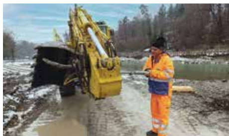
Wartungsarbeit: Schmierfett für den Bagger, damit er weiter rundläuft.
