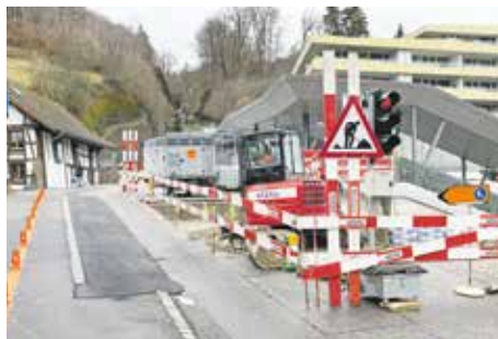
Bauarbeiten an der Dorfstrassenbrücke: Die Gemeinde ruft die Verkehrsteilnehmer zur Beachtung der Baustellen-Signalisation auf, um Unfälle zu vermeiden.
