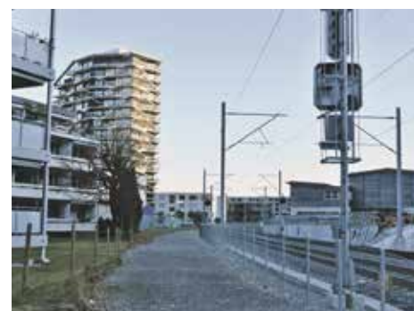
Abschnitt Grünaustrasse–Bächtelenpark: Vor Kurzem noch BLS-Baupiste, bald attraktiver Fuss- und Veloweg
