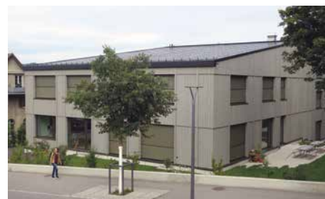
Neubau «Zündhölzli» beim Dorfschulhaus: MINERGIE-P-ECO-Standard, mittels Erdsonden beheizt und mit grossflächiger Photovoltaikanlage auf dem Dach.
