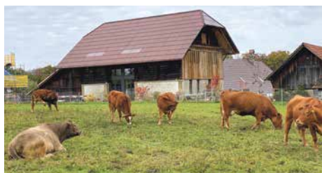
Einstiger Bauernhof Weyergut: Vorbildlicher Umbau mit 100 % CO 2 -freier Wärme- und Stromversorgung (Solarenergie/Wärmepumpe-Erdsonde) für neun Wohnungen. Bild zvg
