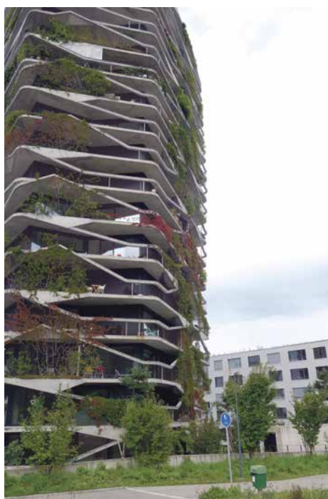
Überbauung Bächtelenpark: erste grösste Siedlungseinheit in Wabern mit weitgehend CO 2 -freier Energieversorgung.
