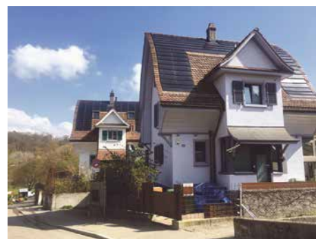
Photovoltaik konventionell, oder aber Dach-/Fassaden-integriert: Beide Varianten stossen auch in Wabern auf stark steigende Nachfrage. Bild pp
