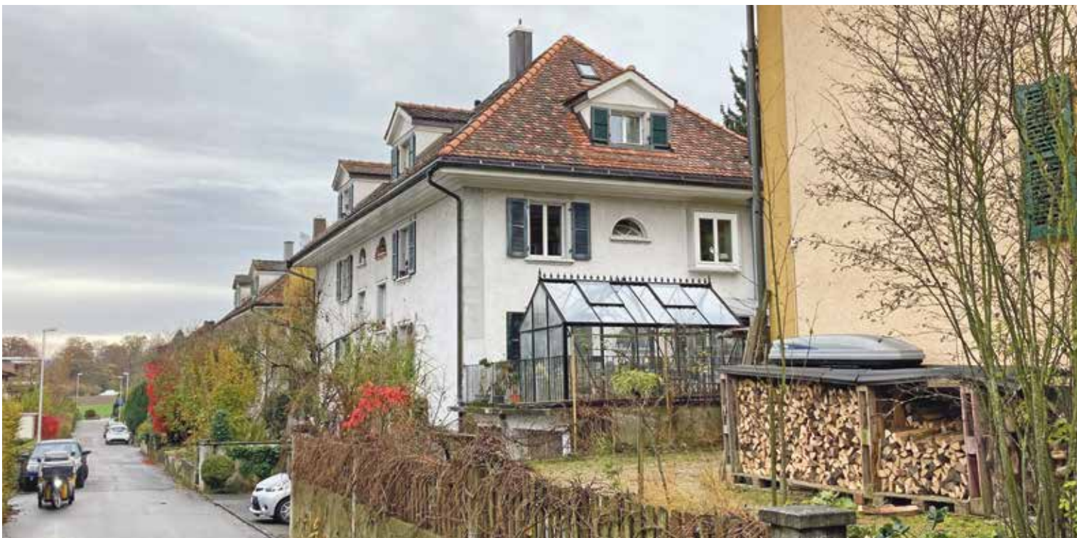
Im Denkmalpflegeinventar als erhaltenswert eingestuft: Die drei Doppel-Wohnhäuser Austrasse Nr. 4-14
