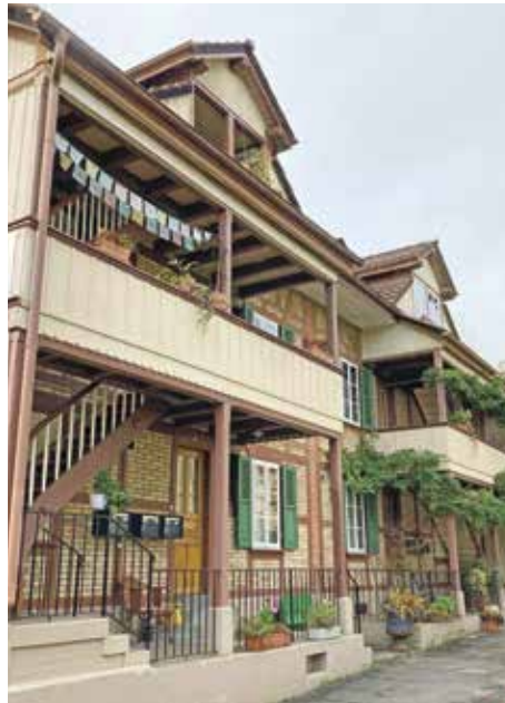
Im Gurtenbühl gelten 7 Objekte als erhaltenswert, darunter das Arbeiter-Doppelhaus Zaunweg 2 und 4 aus dem Jahr 1898
