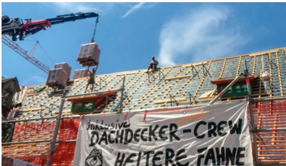
Dachsanierung: Schlussspurt kurz vor dem Dachfest
