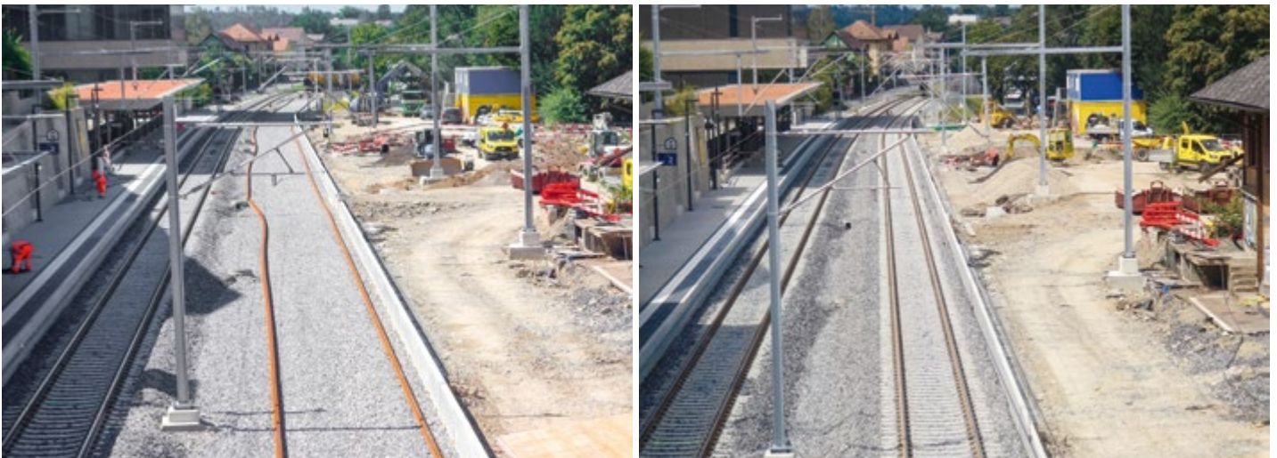
Finale Phase des Doppelspurausbaus im August: innert drei Tagen ein komplett anderes Bild
