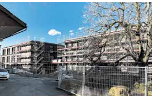
Grünau-Areal ohne Gerüste und Bauzäune? Bald wird's so weit sein.
