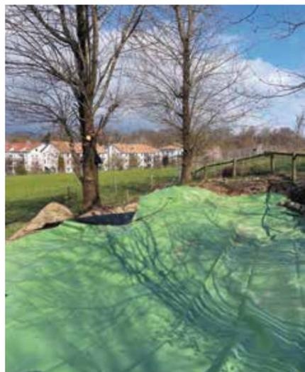
Der Weiher ist ausgehoben und mit der neuen Folie ausgekleidet.
