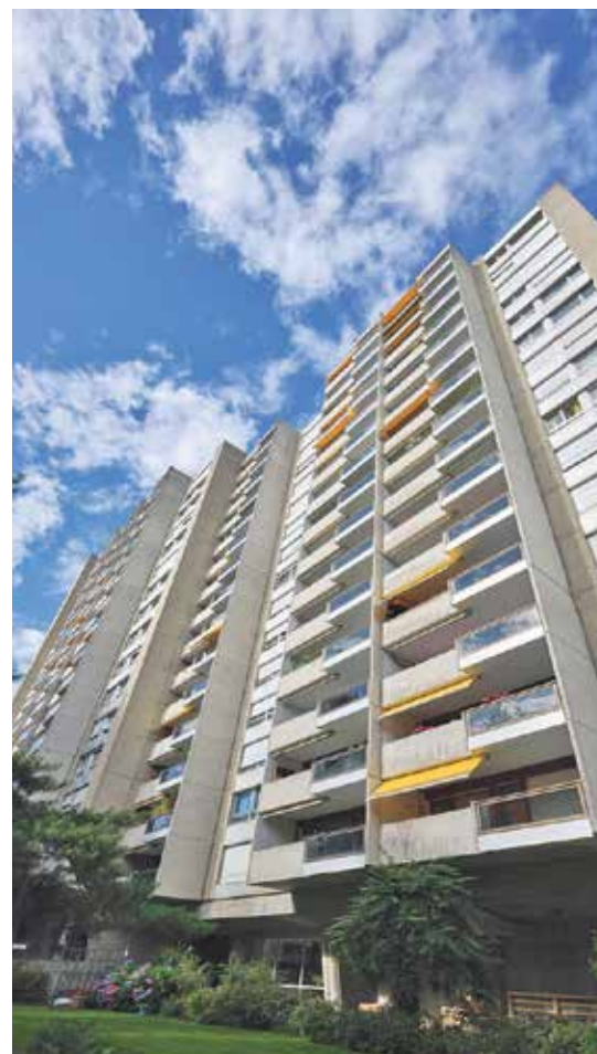
Anstelle der heutigen Gas-Heizzentrale im Eck Bondeli-/Funkstrasse ist die Heizzentrale für den Wärmeverbund Bern-Wabern geplant.
