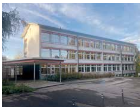
Nicht an den geplanten Wärmeverbund angeschlossen werden soll die Schulanlage Wandermatte, da die Wärmeversorgung bereits seit 2015 CO 2 -neutral mittels Holzpellets erfolgt
