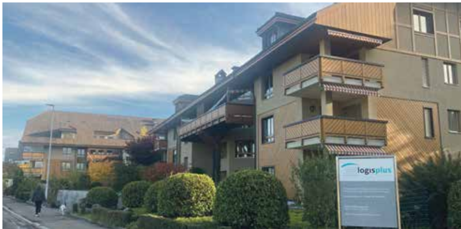
Der Gebäudekomplex am Nesslerenweg 30 wird vorerst leer bleiben
