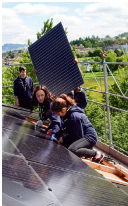
Pios bei der Montage der vierten Falkensteiner PV-Anlage Bild zvg
