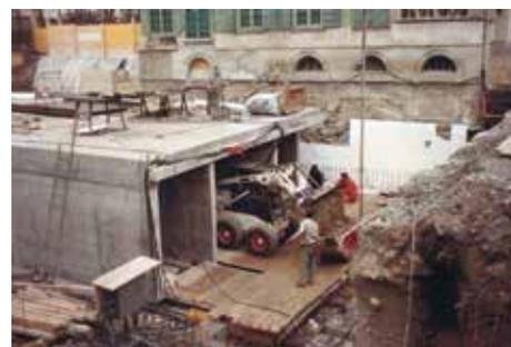
Erstellung der Tiefgarage: Die Baugrube reicht bis zum Gartensaal
