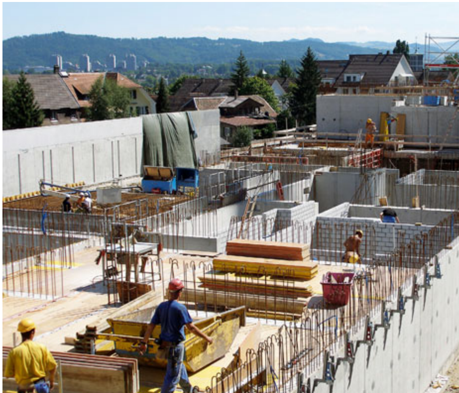
Die zurzeit grösste Baustelle Waberns
